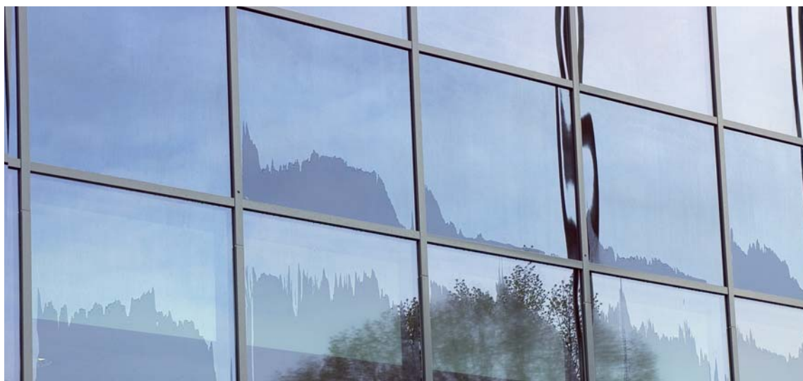
Auf Fenstergläsern haben sich seit einigen Jahren Titandioxid-Beschichtungen, die über selbstreinigende Eigenschaften verfügen, in der Praxis bewährt. (Quelle: Pilkington Deutschland)
