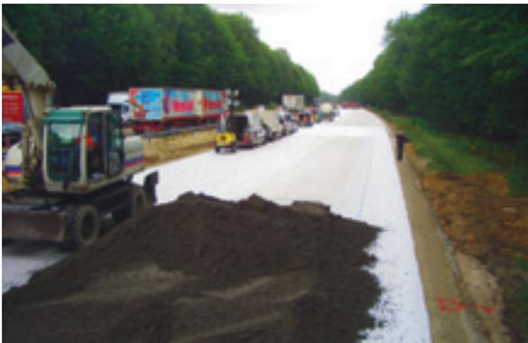
Vorbereiteter Unterbau für eine Betonfahrdecke
