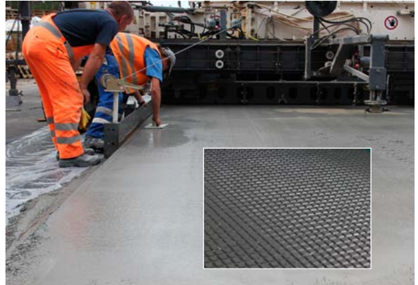
Mit Nanopartikeln optimierter UHPC-Feinmörtel mit eingepprägter lärmreduzierender Textur für eine Betonfahrbahn-Nutzschicht (Quelle: Universität Kassel).
