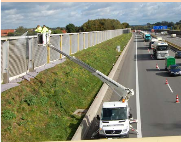
Feldversuch zu photokatalytischer Schallschutzwandbeschichtung (Quelle: Remmers Baustofftechnik GmbH).
