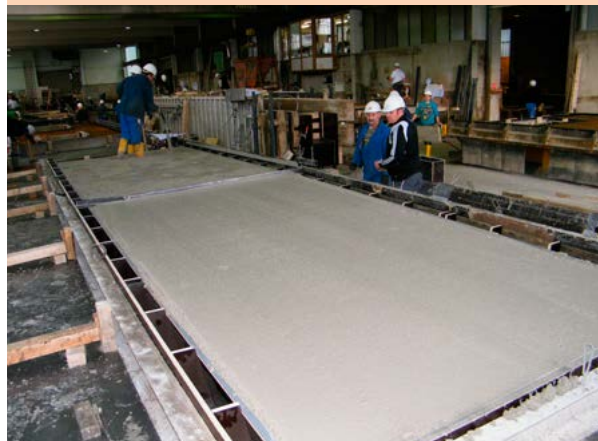
Hergestelltes Brückenelement bei der Fa. Runkel (Quelle: Zoz GmbH).
