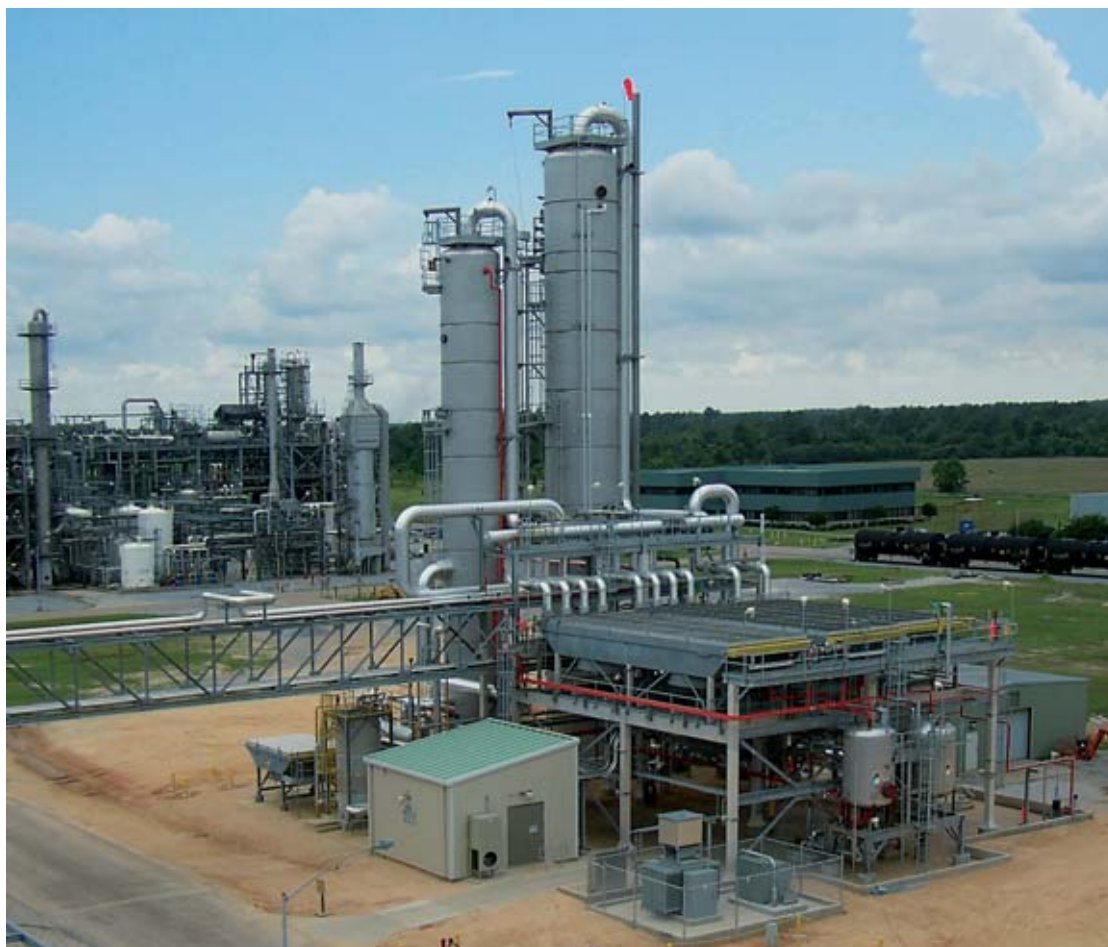
Die neue Anlage zur Herstellung von Natriummethylat von Evonik in Mobile (Alabama, USA)
