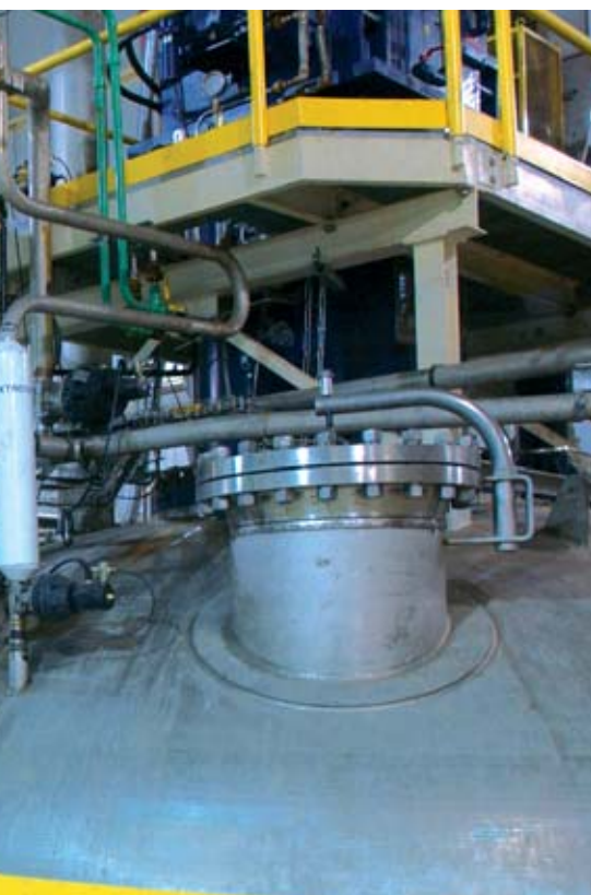
Fermentationsanlage zur Herstellung der Aminosäure L-Lysin bei der amerikanischen Evonik-Tochtergesellschaft Midwest Lysine
